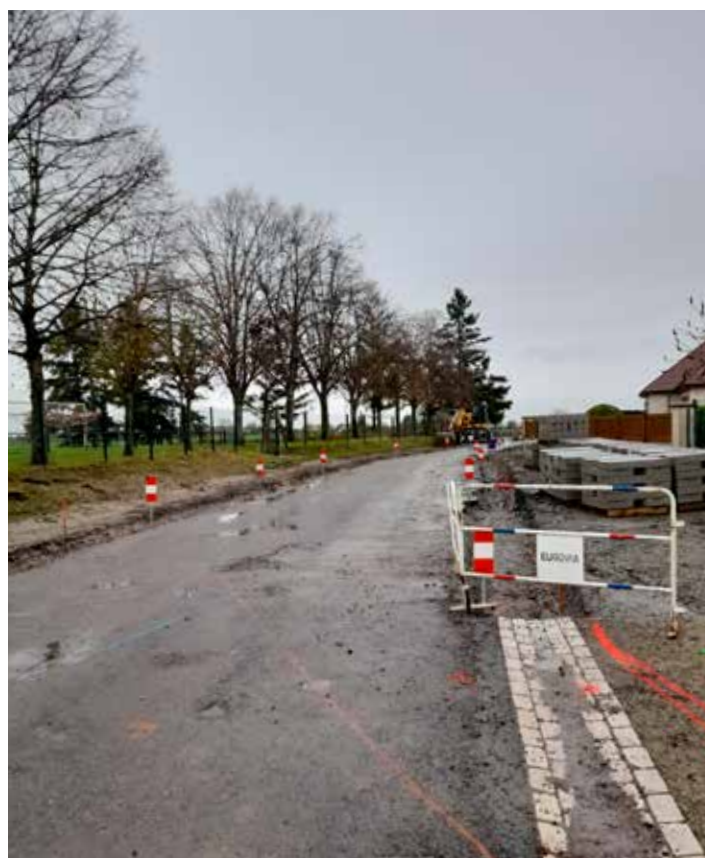
Aménagement de la rue du stade
